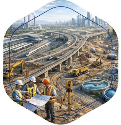
أعمال البنية التحتية Infrastructure Works تنفيذ أعمال الخدمات والمرافق المرتبطة بالمشاريع العمرانية.
